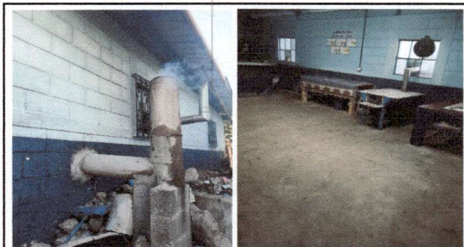
Foto 4: Módulo de COCINA, 20. REPARACIÓN DE COCINA, 20.3 Sustitución de plancha de metal de 3 ornillas, 20.5 Sustitución de Chemenea de concreto, 20.7 Intalación de azulejo en estufa rural. 6. PISO,
