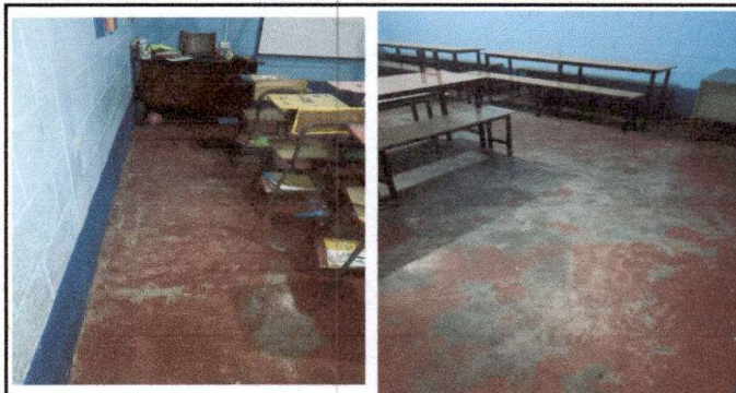
Foto 2: Módulo de Aulas No. 1. 6. PISO, 6.5. Sustitución de piso de torta de concreto.
