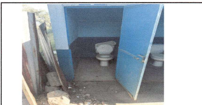
Foto 5: Foto 3: MODULO DE BAÑO, 4. PUERTA DE METAL, 4.1 Mantenimiento a estructura, 4.3 Sustitución de chapas. 10. SERVICIOS SANITARIOS Y SUS ACCESORIOS,
